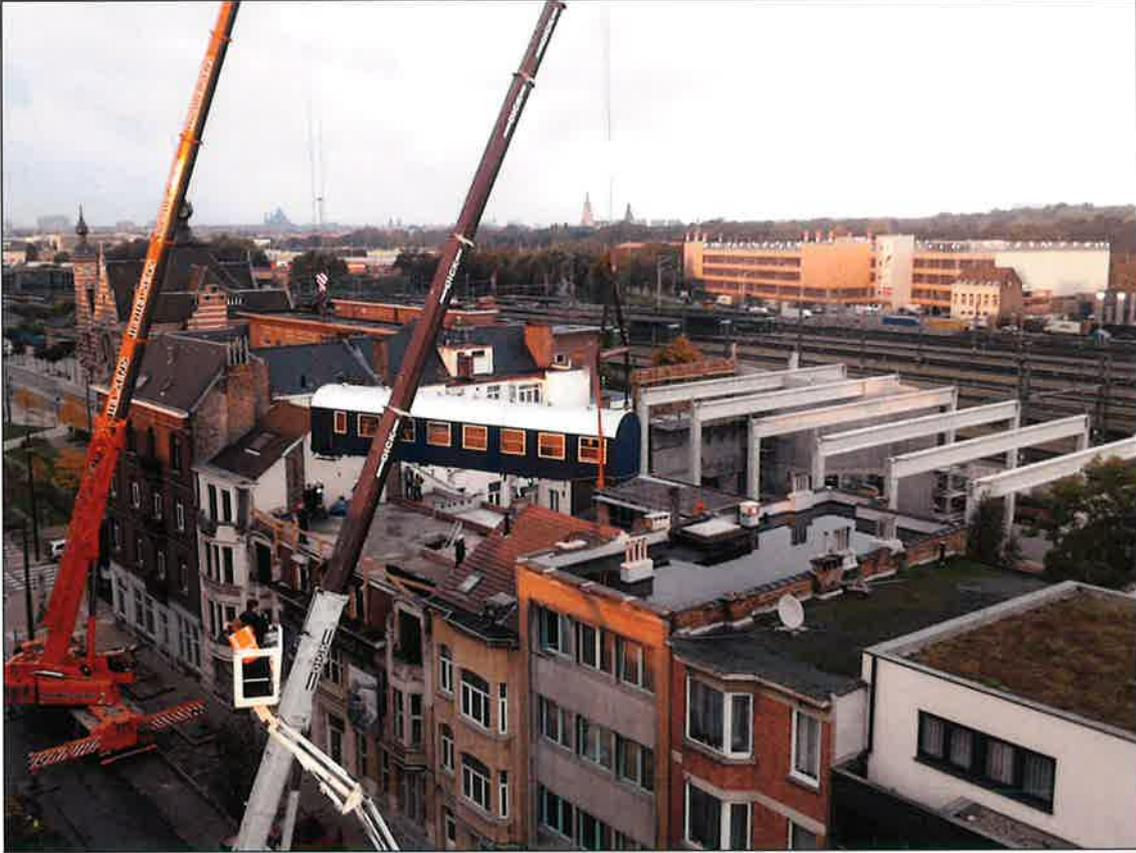
**Photo du haut : 2 grues télescopiques hissent une portion de voiture 15 sur l'arrière de la plate-forme du 2<sup>ème</sup> étage côté cour intérieure pour former, avec ses compartiments, une partie du 3<sup>ème</sup> étage. Six travées de la structure en béton du futur musée sont érigées au centre droit de la vue. Au fond à gauche : l'ancienne gare de Schaerbeek restaurée sert d'entrée au musée "Train World" (photographe inconnu, 26 octobre 2013).**
